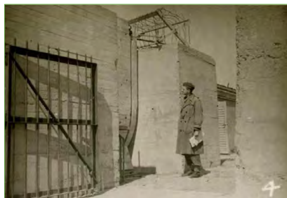
Naoorlogse foto van de toegang tot het Kernwerk, ook wel het Reinhardwerk genaamd. Foto G.Forest/Stichting Menno van Coehoorn.
