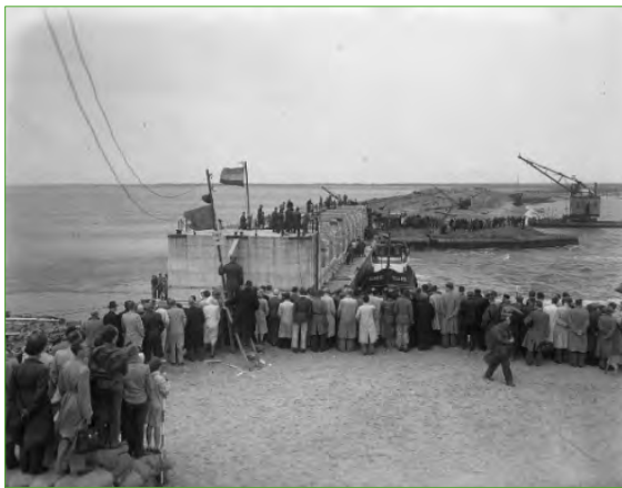
Het laatste caisson wordt ingevaren, juli 1950. Foto R. Winterbergen/collectie Nationaal Archief.
