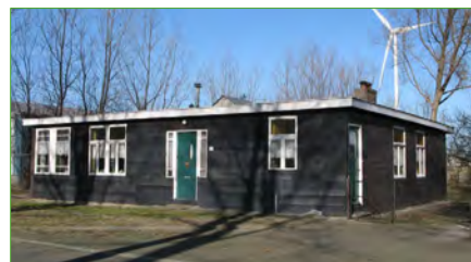
Hetzelfde huis als hiervoor maar dan aan de Dintelweg in Europoort. Het huis werd in twee delen naar de nieuwe bestemming vervoerd. Na de reconstructie was de naad duidelijke zichtbaar. Foto Buijsman.
