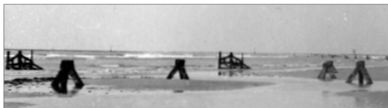
Links en rechts van het midden Cointet-elementen 41 . Verder betonnen tetraëders of mijnstoelen. Alles om landingsboten te hinderen. Foto Hans Sakkers.
