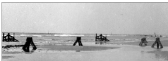
Links en rechts van het midden Cointet-elementen, ook wel Belgsiche poorten genoemd. Verder betonnen tetraëders of mijnstoelen. Alles om landingsboten te hinderen. Foto Hans Sakkers.
